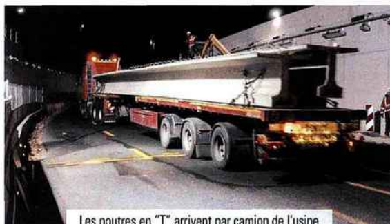
Les poutres en "T" arrivent par camion de l'usine de Celles-sur-Belles (79).
